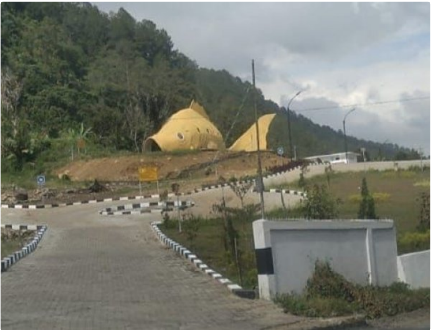
Proyek Pembangunan Ikan Mas Sipolha
